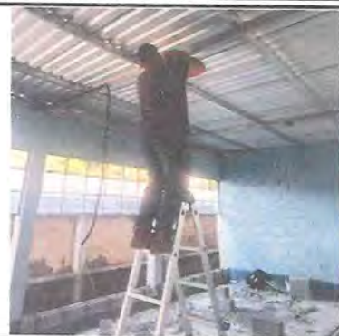
Foto 2: Ducteado para sustitución de sistema eléctrico en aulas.
