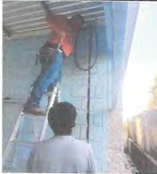
Foto1: Durante ducteado para sustitución de sistema eléctrico.
