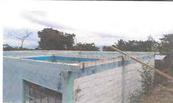
Foto 4: Nivelación de paredes para colocar estructura metálica.
