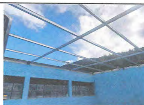
Foto 6: Estructura metálica parte interior de aulas.
