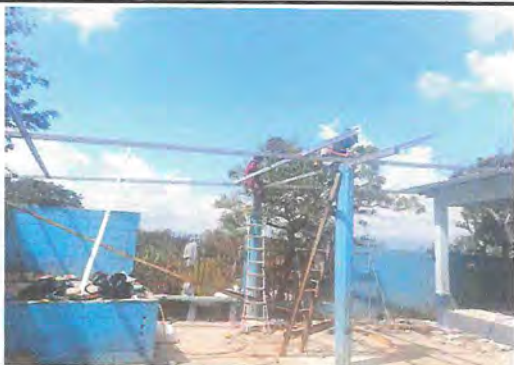
Foto1: Durante colocación de costaneras en corredor.
