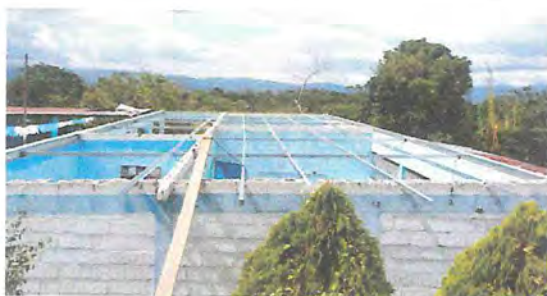
Foto 5: Durante la colocación de estructura metálica.
