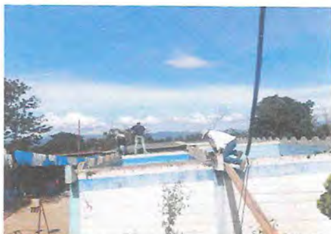
Foto 1: Durante el desmontaje de techo de aulas.
