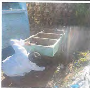
Foto 5: Durante sustitución de pilas de cemento.
