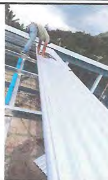
Foto 2: Durante enlaminado en corredor.
