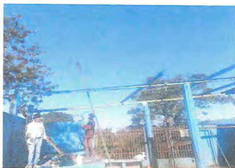
Foto 3: Durante el desmontaje de techo en corredor.
